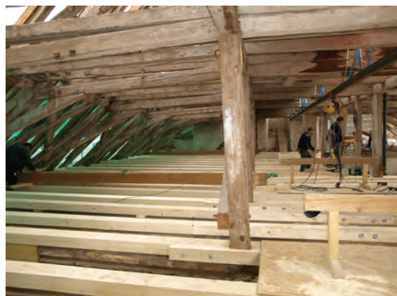
Hier wurden bereits die sogenannten Zerrbalken eingebaut
