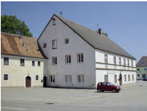
Die Hofwirtschaft vor dem Umbau
