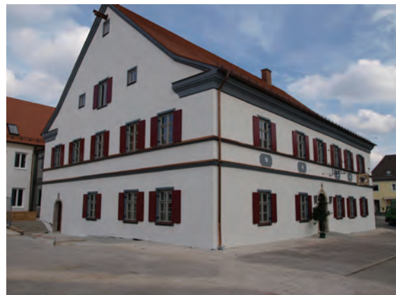
Blick auf die West- und Südseite am 25.09.2009.
