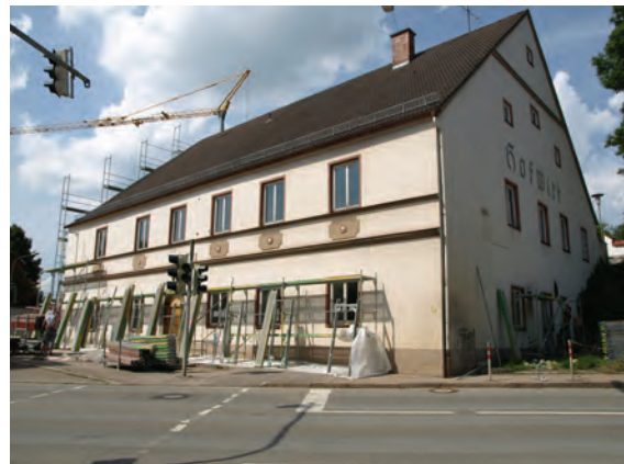
30.07.2008: Blick auf die Süd- und Ostseite vor dem Gerüstaufbau
