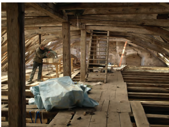
Der Blick in ein Dachgeschoss
